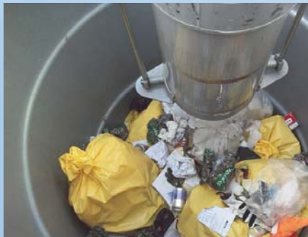
Odsávání komunálního odpadu z podzemního kontejneru
