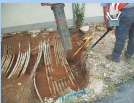
Bezpečné odkrývání inženýrských sítí
