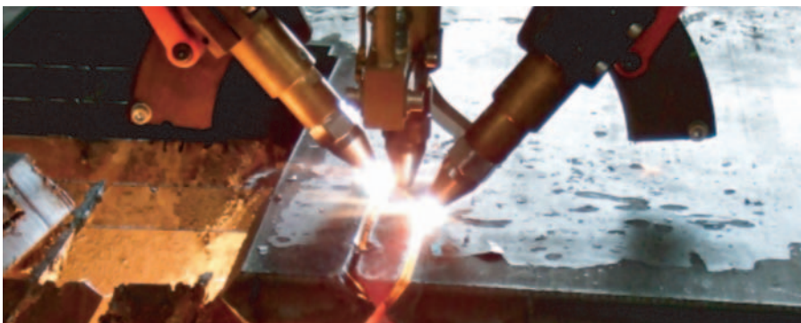
Pro realizaci K řezů je nejvhodnější tříhořákový autogenní rotátor.
